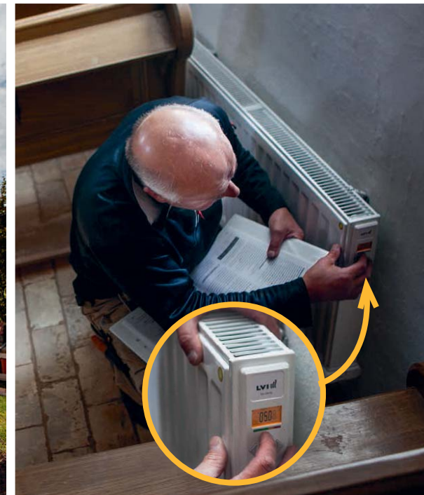
Flexibel styrning. Mats Andersson har installerat all el i kyrkan. De nya LVI-radiatorerna kan styras på flera olika sätt, via display, mobilapp eller webbsida.
